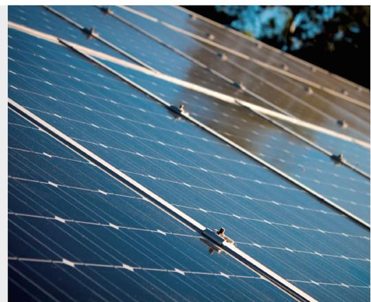
Die Häufigkeit der Reinigung hängt von der Geschwindigkeit der Schmutzansammlung ab. In normalen Situationen reinigt Regenwasser die Moduloberfläche und verringert die Reinigungshäufigkeit. Es wird empfohlen, Schwämme mit sauberem Wasser oder weiche Tücher zu verwenden, um die Glasoberfläche abzuwischen. Verwenden Sie zum Reinigen der Module keine sauren und alkalischen Reinigungsmittel. Verwenden Sie zum Reinigen auf keinen Fall ein Werkzeug mit rauer Oberfläche.
