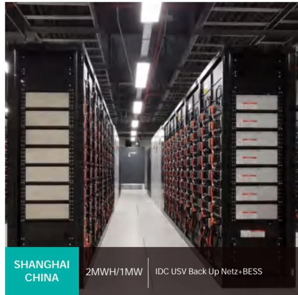
**SHANGHAI CHINA** | 2MWH/1MW | IDC USV Back Up Netz+BESS
