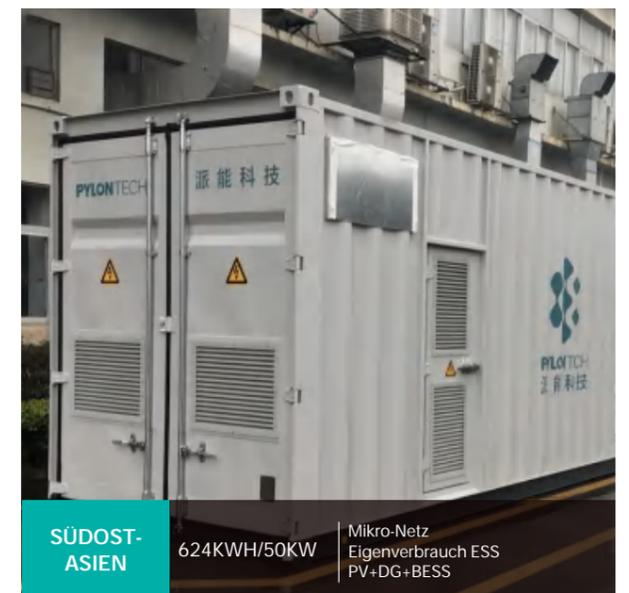
**SÜDOST-ASIEN** | 624KWH/50KW | Mikro-Netz Eigenverbrauch ESS PV+DG+BESS
