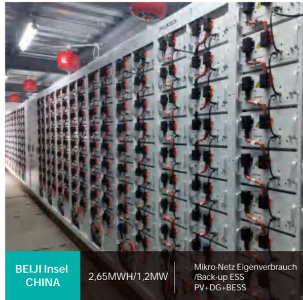
**BEIJI Insel CHINA** | 2,65MWH/1,2MW | Mikro-Netz Eigenverbrauch /Back-up ESS PV+DG+BESS
